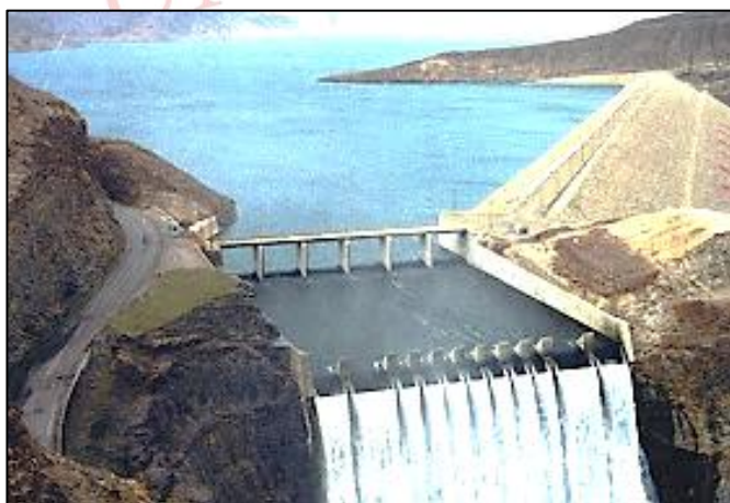
La represa de Gallito Ciego, obra de gran importancia que embalsa las aguas del río Jequetepeque.
