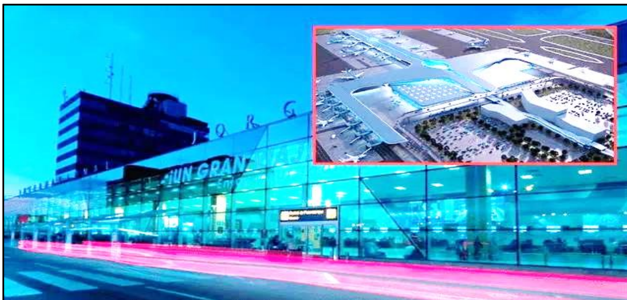
Nuevas instalaciones del Aeropuerto Internacional Jorge Chávez - Callao
