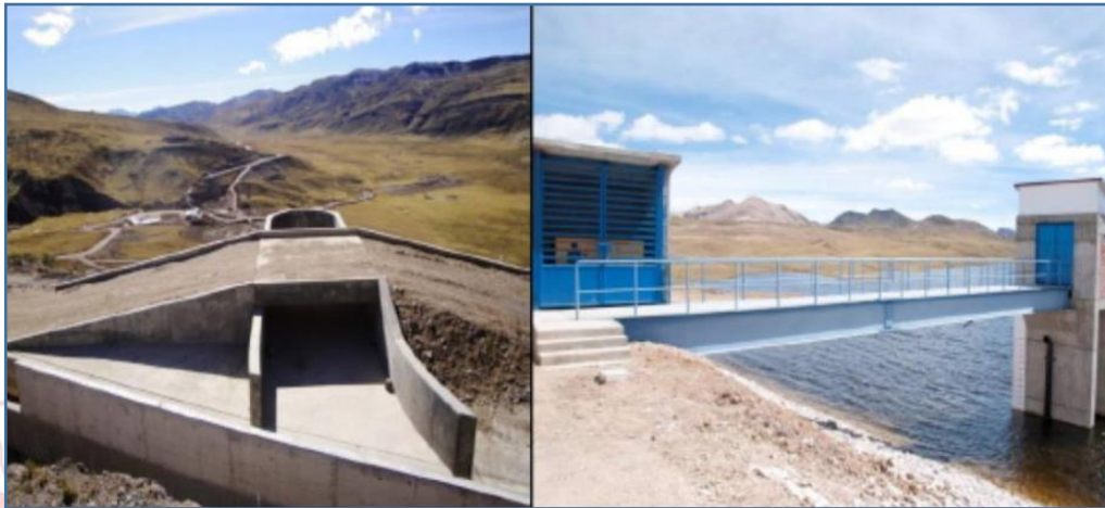
Sistema de derivación de Huascacocha
