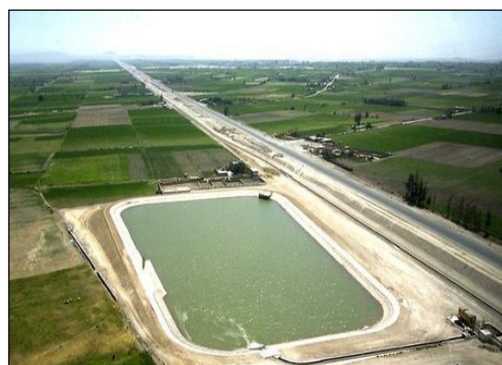
Obra de irrigación Majes
