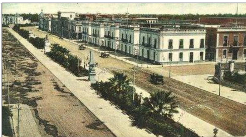
Paseo Colón, se observa los postes de alumbrado eléctrico conectados por cables. En distintas partes del país se construyeron plantas generadoras de energía eléctrica.
