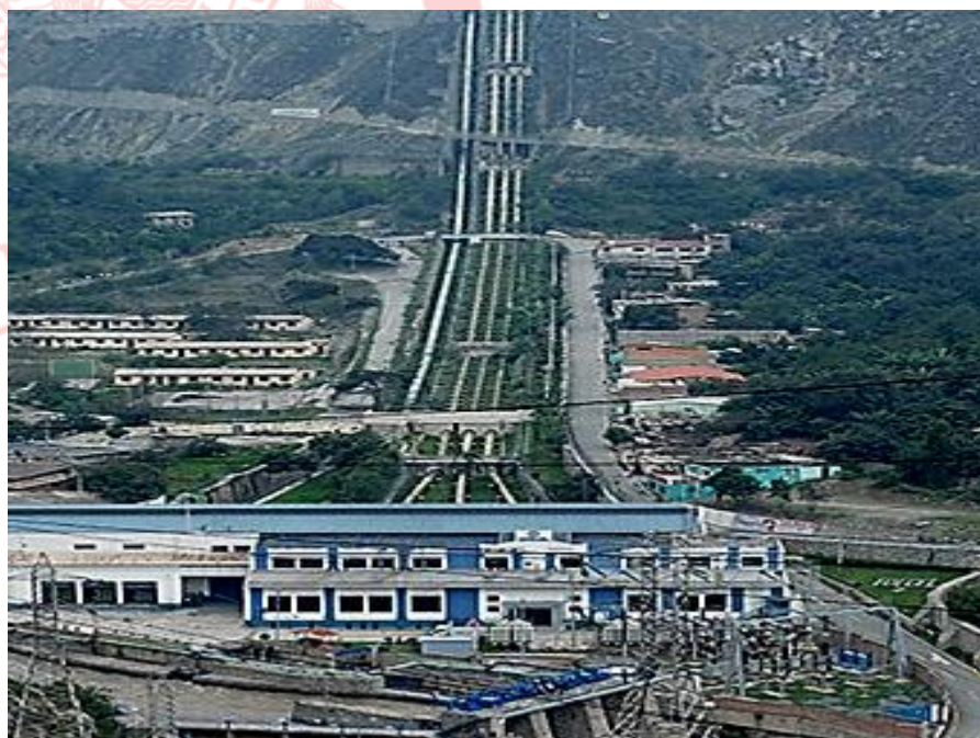
Central Hidroeléctrica de Callahuanca
