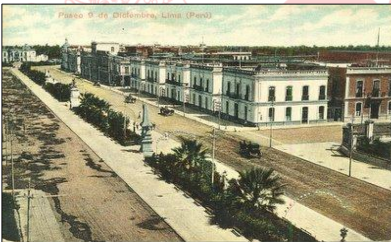
Paseo Colón, se observa los postes de alumbrado eléctrico conectados por cables. En distintas partes del país se construyeron plantas generadoras de energía eléctrica.
