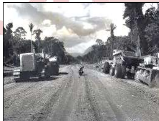
CARRETERA MARGINAL DE LA SELVA
