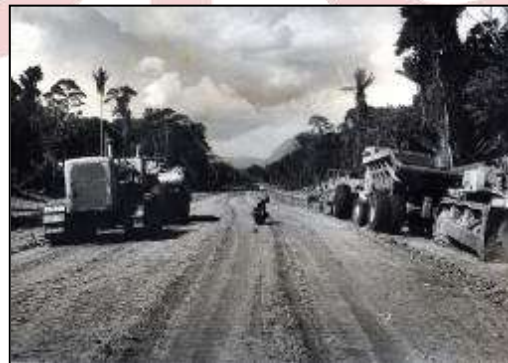
CARRETERA MARGINAL DE LA SELVA
