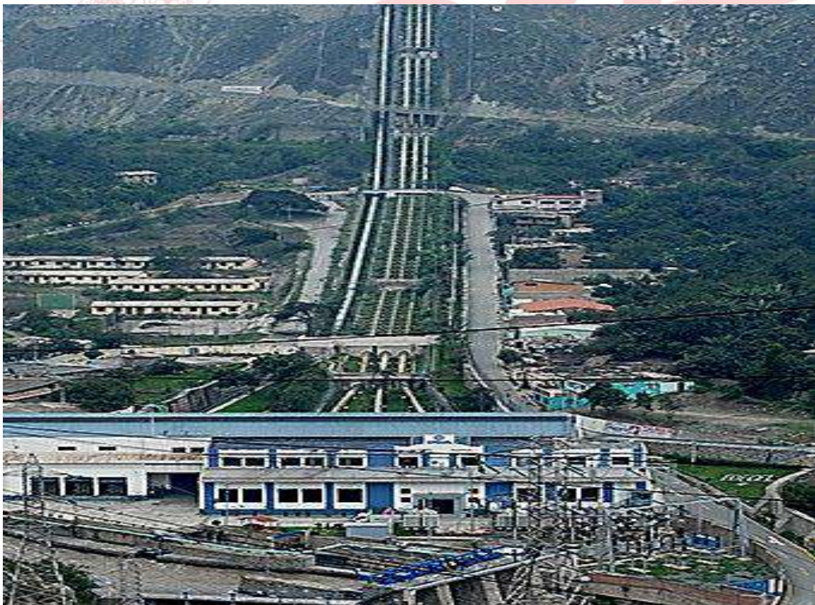
CENTRAL HIDROELÉCTRICA DE CALLAHUANCA
