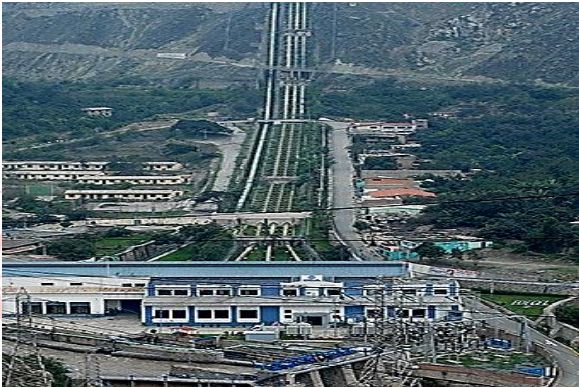
CENTRAL HIDROELÉCTRICA DE CALLAHUANCA
